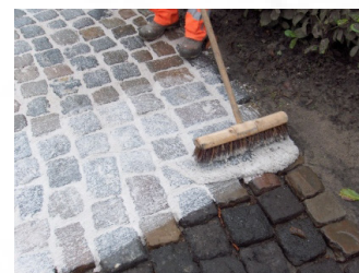
Uitgieten SP II op vochtige bestrating en met bezem in de voegen vegen
